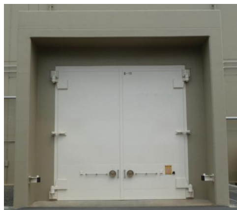
原子炉建屋大物搬入口 (対策前)
