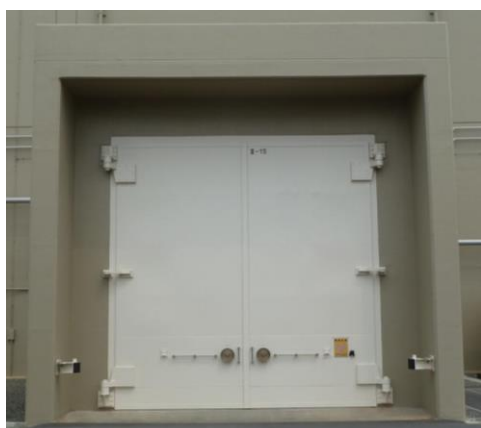
原子炉建屋大物搬入口 (対策前)
