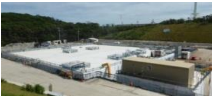
共用緊急時淡水貯槽：容量約10000m 3 (5000m 3 の2槽構造)
