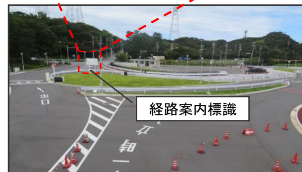
敷地内道路等の整備状況 (正門から国道側を撮影)
