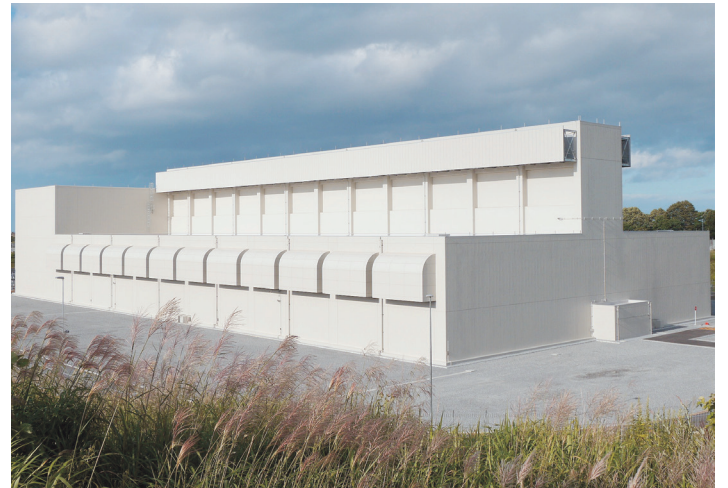
【リサイクル燃料備蓄センター貯蔵建屋1棟目：3,000トン】
