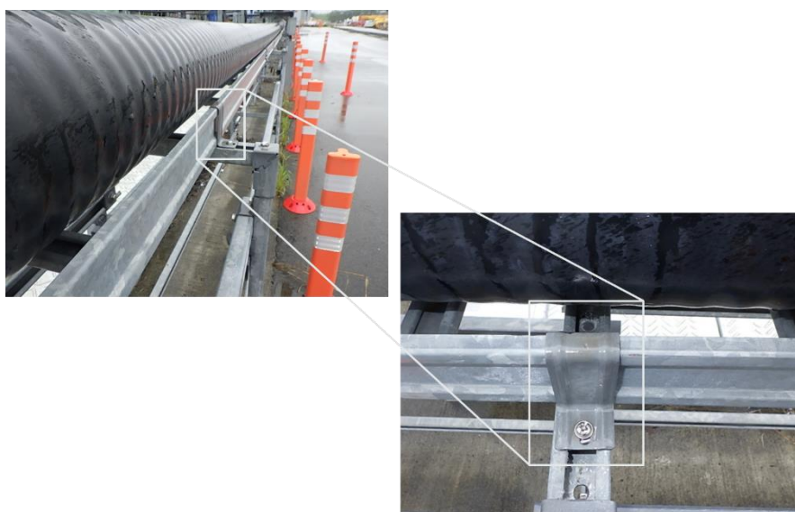
(b) 配管ラックの固定状況
