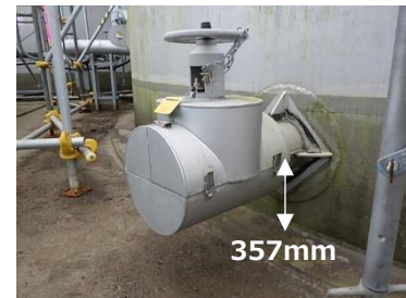
出口管台 (ALPS 処理水移送ポンプへ)
