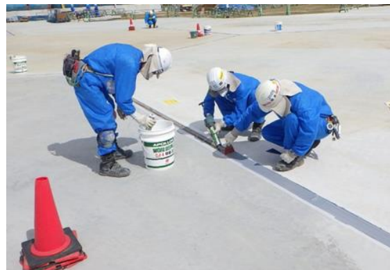
図 2.14.1.4-16 目地シーリング施工状況
