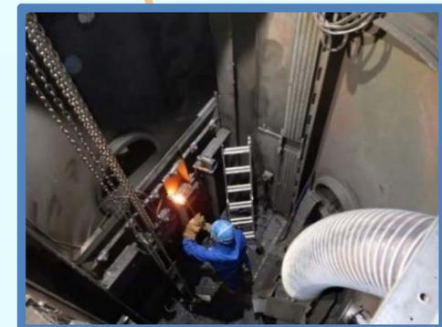
湿水分離器内部構造物の切断
