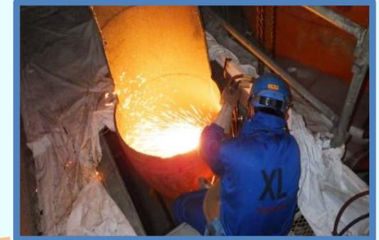
高圧タービン排気配管の切断
