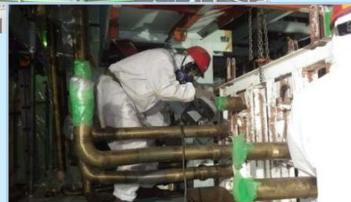
入口管の切断作業
