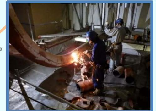
主蒸気管 (高圧タービン入口配管) の切断
