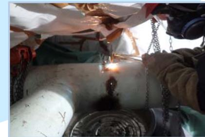
ECCS系配管の切断作業
