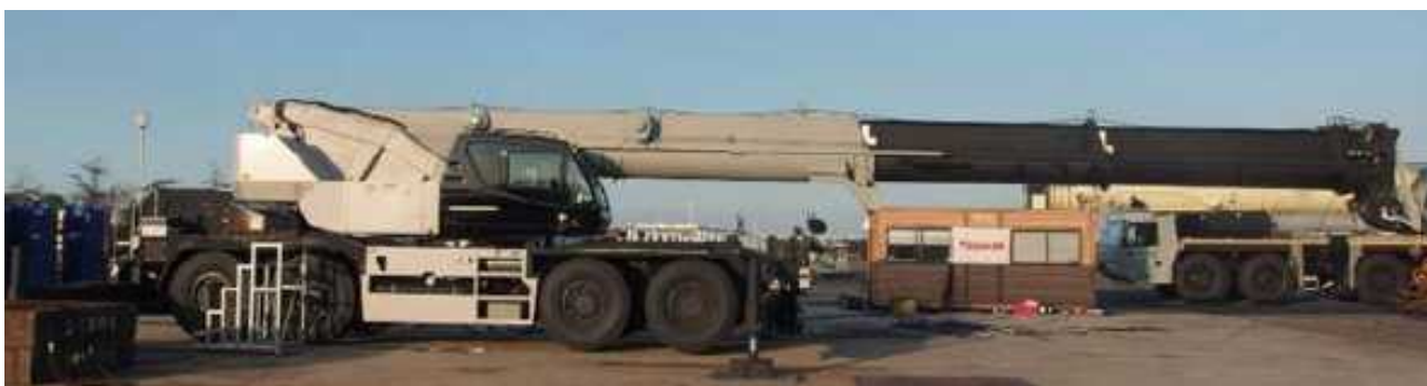
②燃料取扱機 (起伏角度0°／ブーム長さ19.1m)
