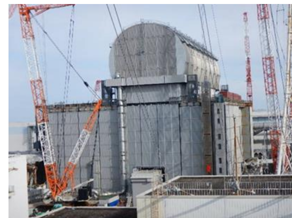
3号機原子炉建屋外観写真の例
