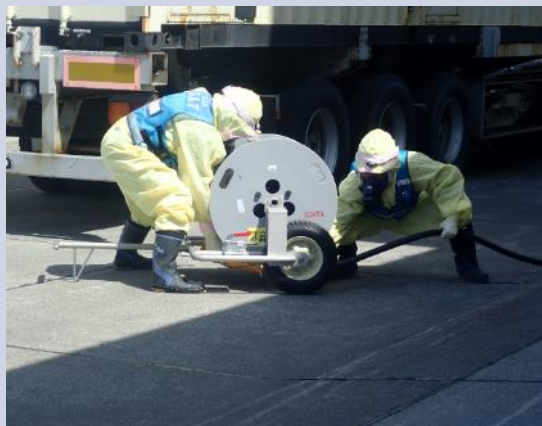
ケーブル敷設
