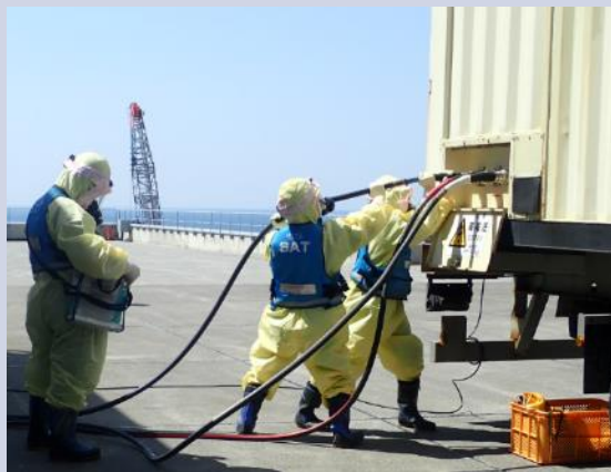
ケーブル接続
