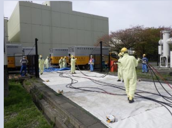
ケーブル敷設
