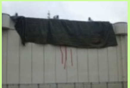
外壁の破損を想定した養生訓練
