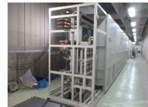
盤枠外装板撤去
