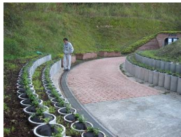
法面の土留め対策及び見学坑道周辺に花壇を設置
