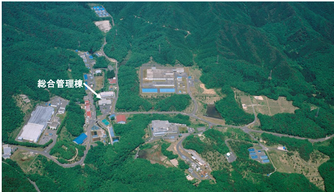
人形峠環境技術センター全景
