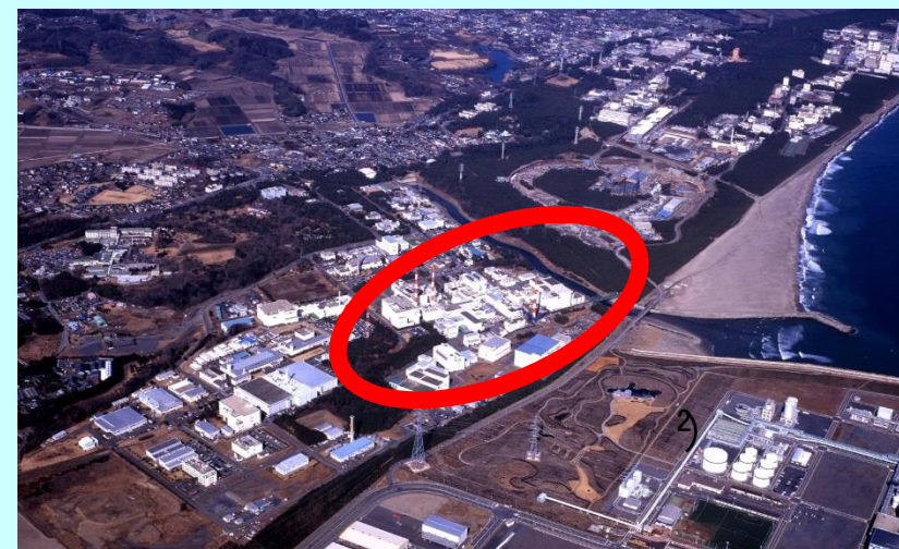
現在(管理区域を有する約30施設)
