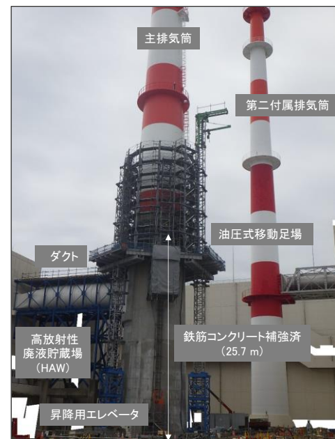
主排気筒の筒身補強工事の状況(令和4年4月)
