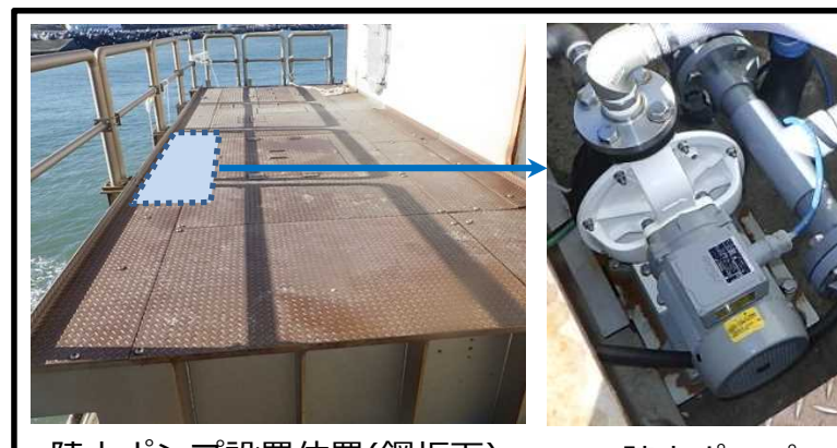
陸上ポンプ設置位置(鋼板下) 陸上ポンプ 写真3
