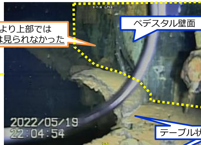
写真4.ペDESTAL開口部(右側基礎部)の堆積物より上部の状況
