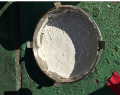
内面への接着剤塗布後
