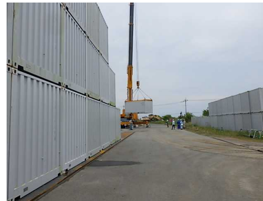
積み直し作業実施状況
