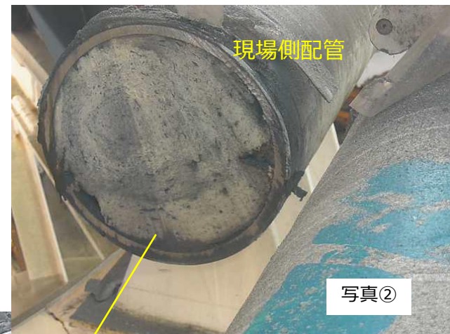
下流側 (排気筒側)
