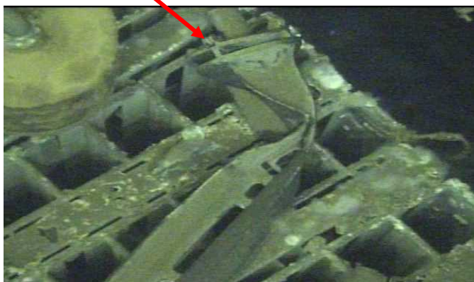
制御棒下部に変形
