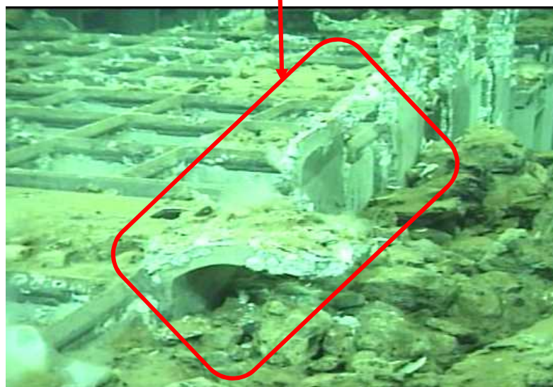
吊りピース変形
