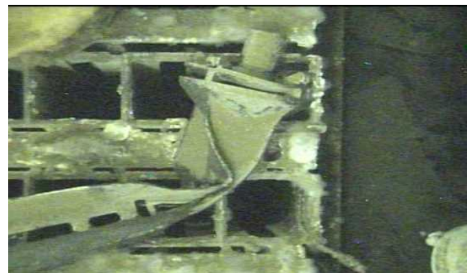
制御棒下部に変形
