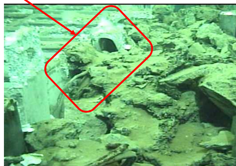
吊りピース変形
