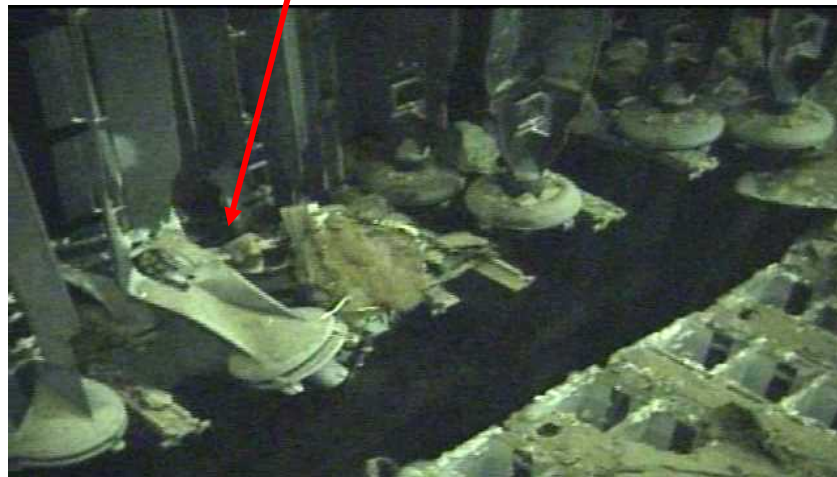
制御棒下部に変形
