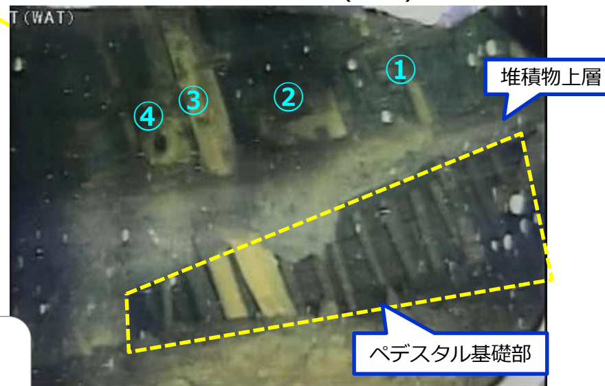
写真2.ペDESTアル基礎部(下部)の状況
