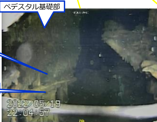
写真2.ペDESTAL開口部(左側基礎部)の堆積物を堺にした上下部の状況
