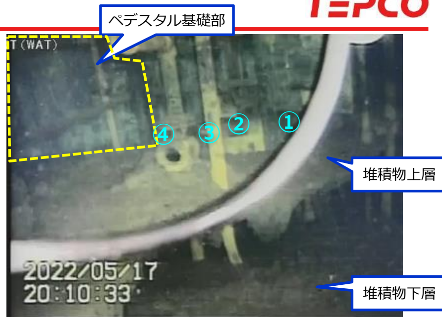
写真1.ペDESTアル基礎部(上部)の状況
