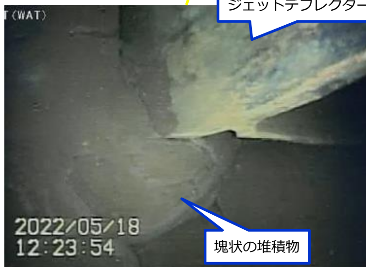
写真2.ジェットデフレクター(E)表側下部の状況
