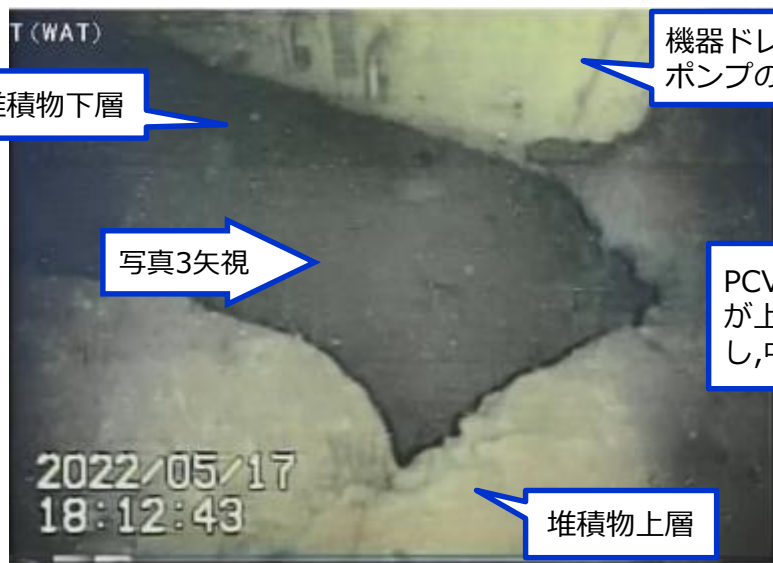
写真2.PCV底部の堆積物の状況
