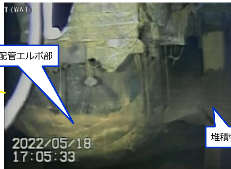
写真1.PLR(A)配管の状況
