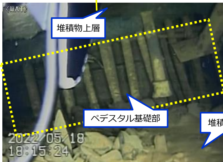
写真2.ペDESTAL基礎部付近の状況
