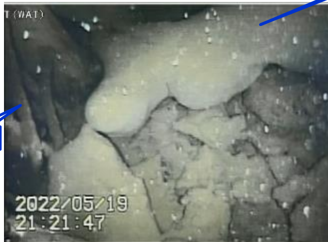
写真2.ペDESTAL開口部(内部手前)の状況
