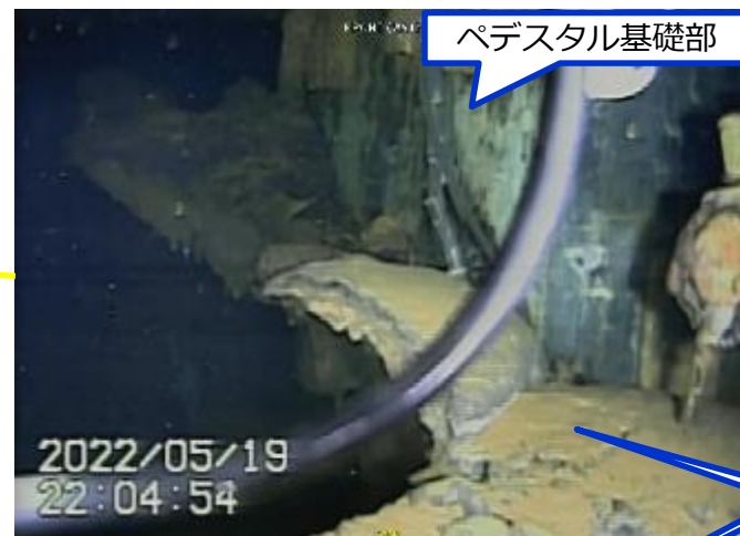
写真1.ペDESTAL開口部(右側基礎部)の堆積物より上部の状況
