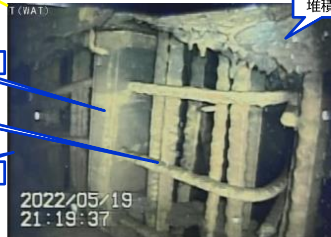
写真2.ペDESTAL開口部(右側基礎部)の状況
