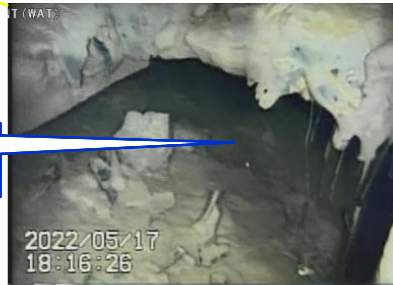
写真3.PCV底部の堆積物の状況(空洞内部)
