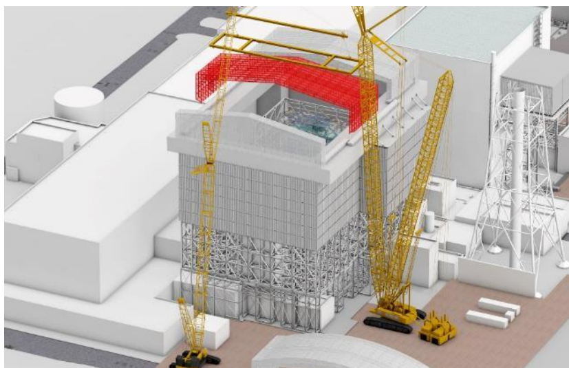
可動屋根設置中
