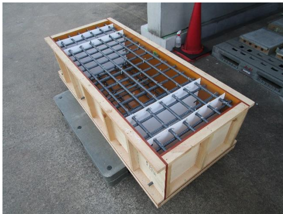
引抜試験体 打設前
