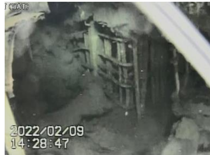
A. ペDESTAL開口部付近
