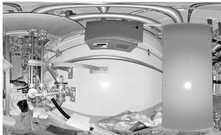
3階シェル壁南西面（写真）
