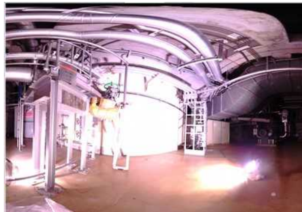
3階シェル壁北東面（写真）
