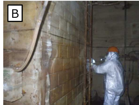
地下1階内壁面B
