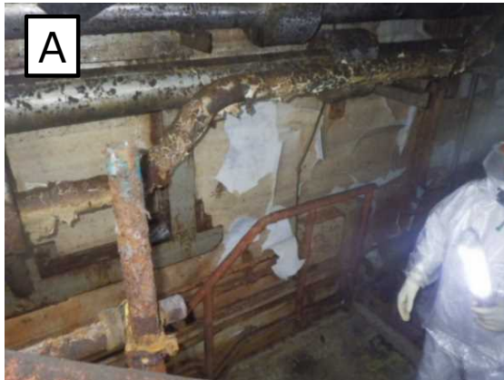
地下1階内壁面A
