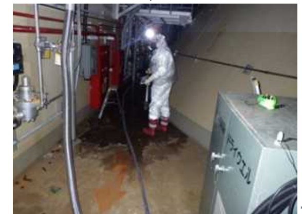
写真 d : 北東面
