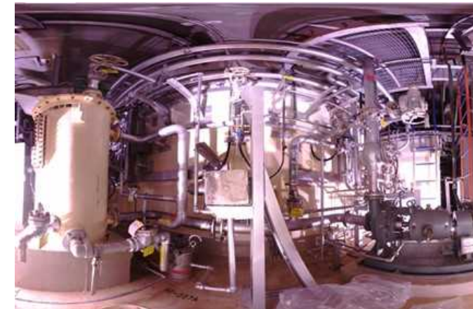
3階プール壁西面（写真）
