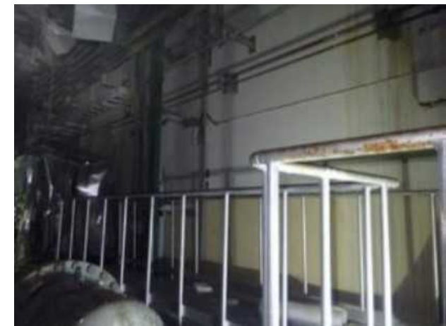
4階プール壁西面（写真）
