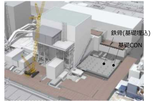
③構台鉄骨建方(0層)・基礎CON打設完了
