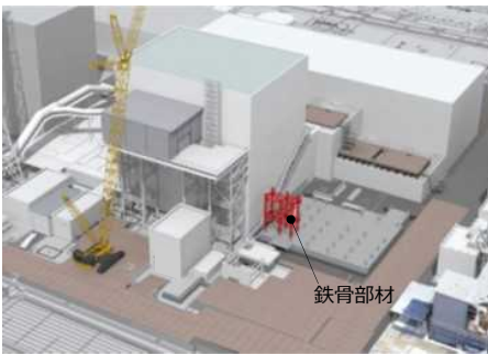
④構台鉄骨建方(1層目開始)
