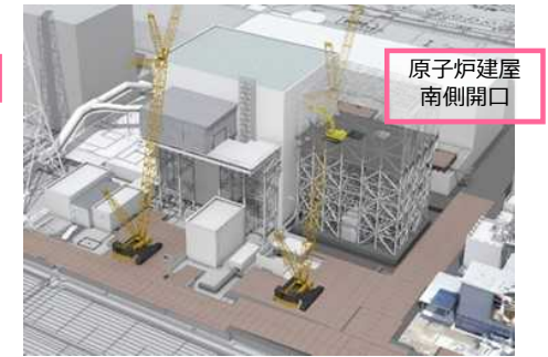
⑨南側開口設置
