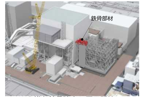
⑥構台鉄骨建方(3層目開始)
