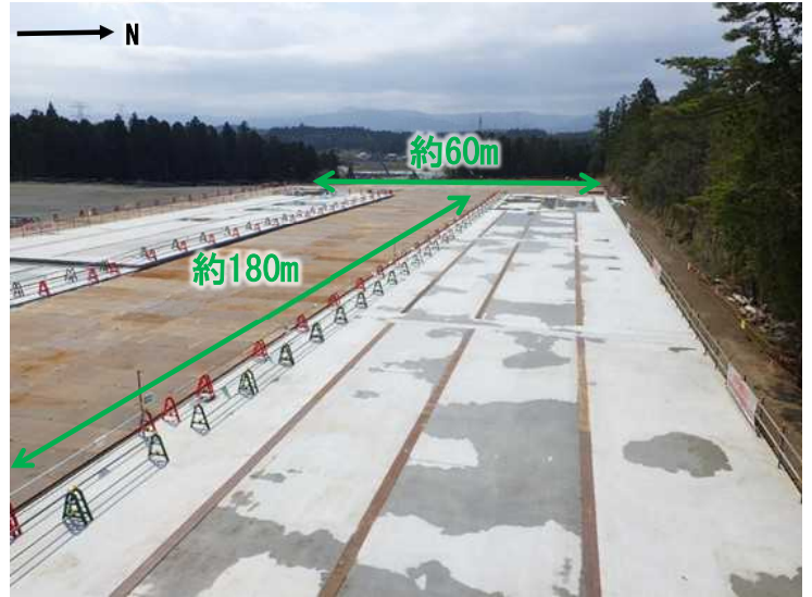
構外地組ヤード全景（撮影：2022.4.20）
