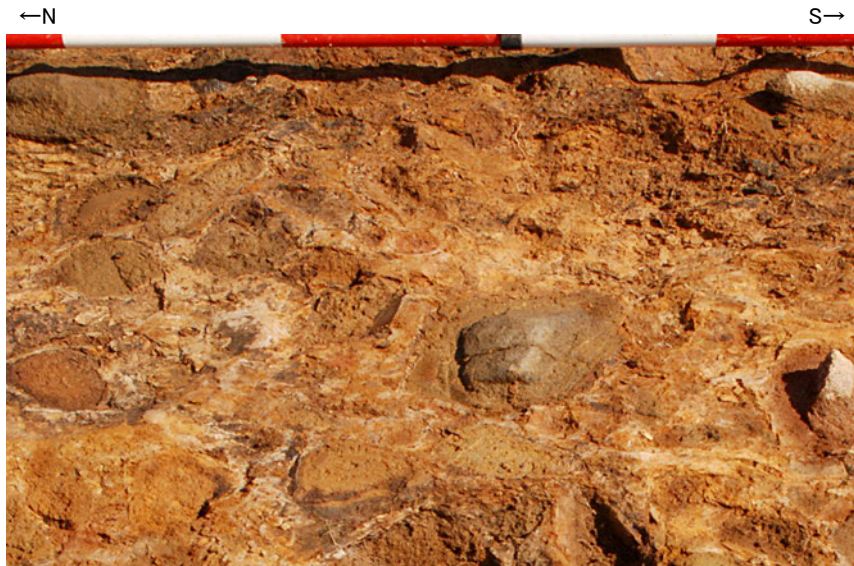
35m盤法面 堆積物の拡大写真
