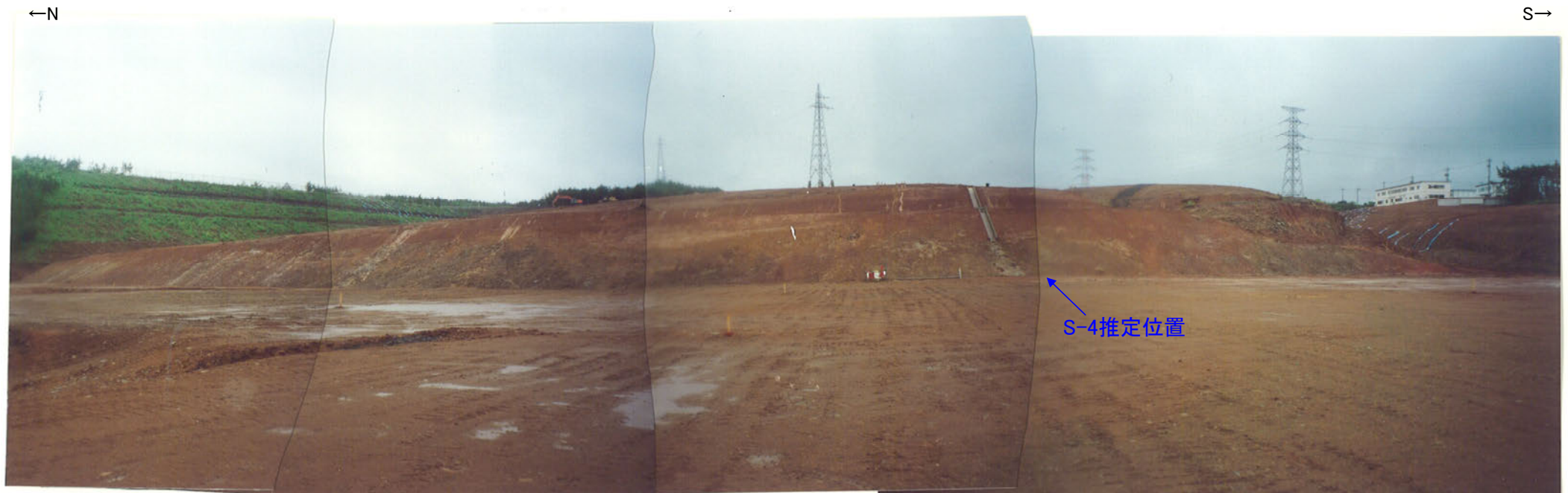
写真(2号機建設時)
