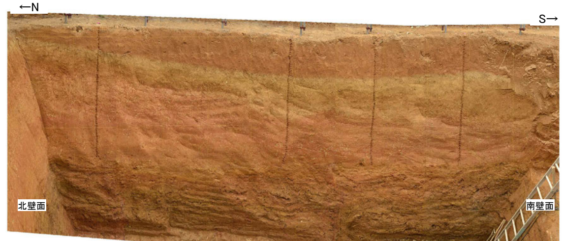
写真(えん堤左岸トレンチ 東壁面)
