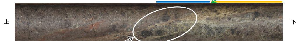
ボーリングコア写真(R-8.1-1-2孔)
