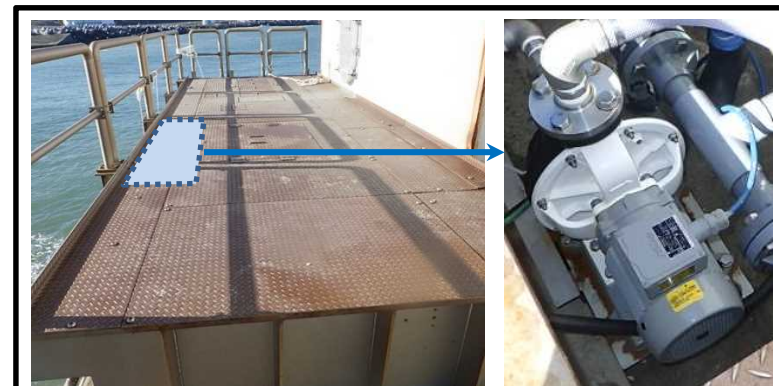
陸上ポンプ設置位置(鋼板下)
