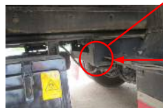
固縛用リング取付箇所
