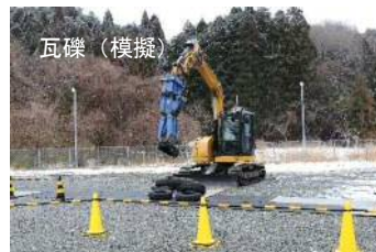
無線重機による瓦礫除去
