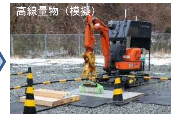
無線重機による高線量物除去
