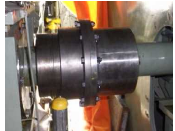
ギアカップリング交換後(塗装前)
