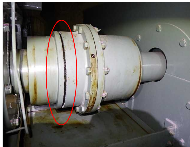
ギアカップリングカバー損傷部
