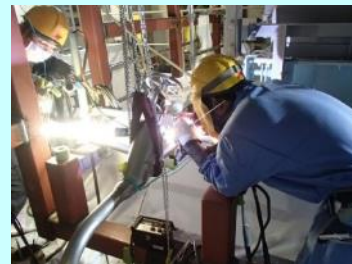
抜き取り用配管・弁設置
