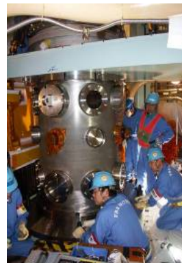
炉内中継装置引抜き時のカバーガスバウンダリ確保のための仮設治具設置作業
