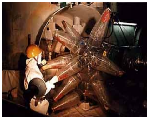
プラバックを用いた温度計部切断作業
