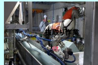
ナトリウム抜き取り作業
