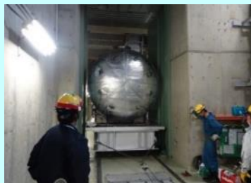
一時保管用タンク据付
