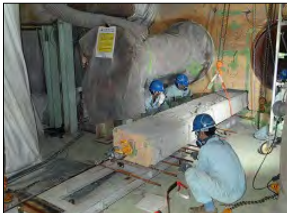
コンクリートブロックの引抜き
