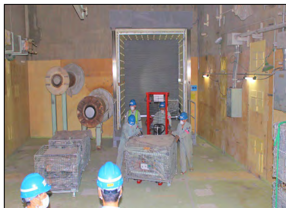
運用開始 (解体撤去物の搬出)
