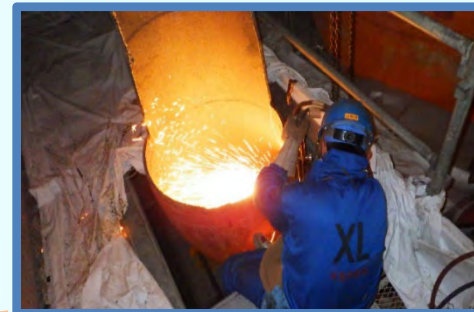
高圧タービン排気配管の切断 (2017. 6. 23)
