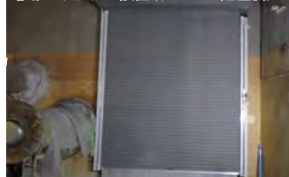
シャッター設置完了
