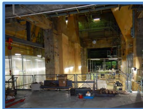
復水器解体撤去後 (2018. 3. 23)
