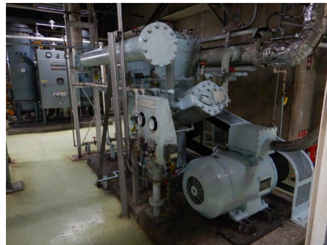
既設の空気圧縮機
