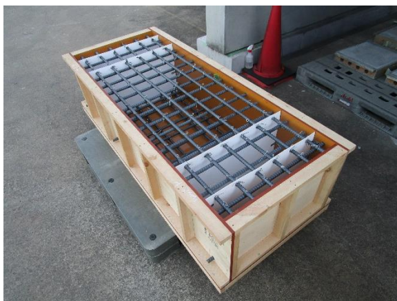
引抜試験体 打設前
