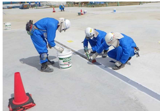
図 2.14.1.4-16 目地シーリング施工状況
