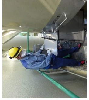
閉止板取付作業
