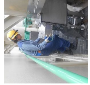
フィルタ抜取作業
