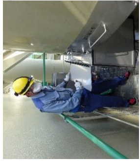
閉止板取付作業
