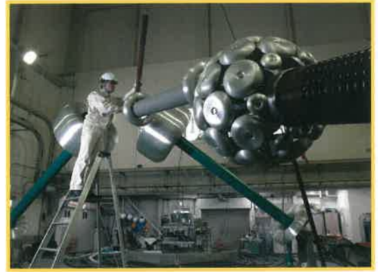
CVケーブル絶縁特性試験設備
