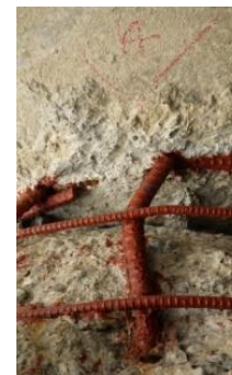
No.8杭主筋の変形状況
