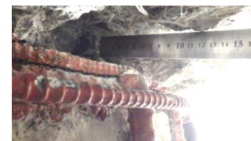
No.8杭主筋の破断状況
