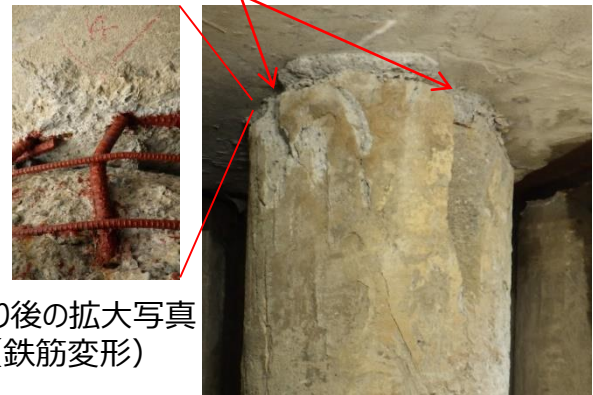
No.8杭の杭頭部の損傷状況 杭頭部がせん断により損傷
