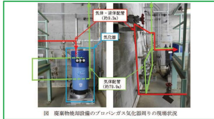
図 廃棄物焼却設備のプロパンガス気化器回りの現場状況
