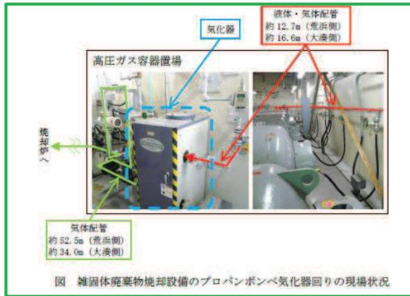
図 雑固体廃棄物焼却設備のプロパンボンベ気化器回りの現場状況
