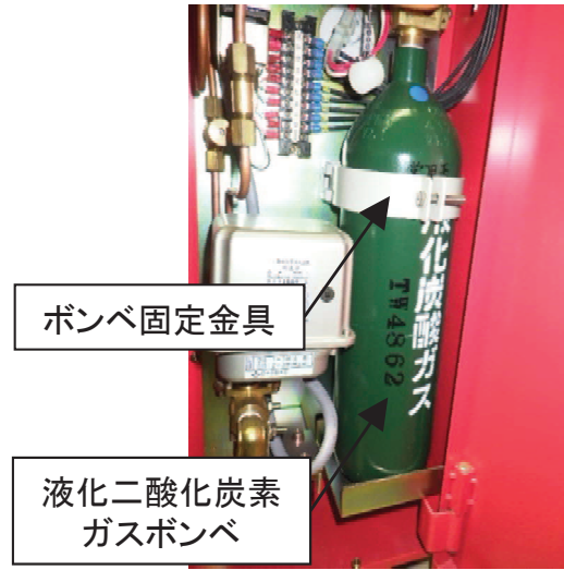
図17 発電所におけるボンベの設置状況
