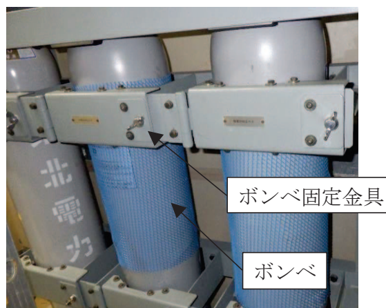
【2号炉原子炉建屋】 酸素ガスポンベ
