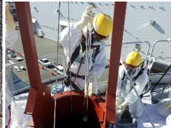
攪拌実証試験当日の採水の様子
