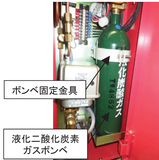
図17 発電所におけるボンベの設置状況
