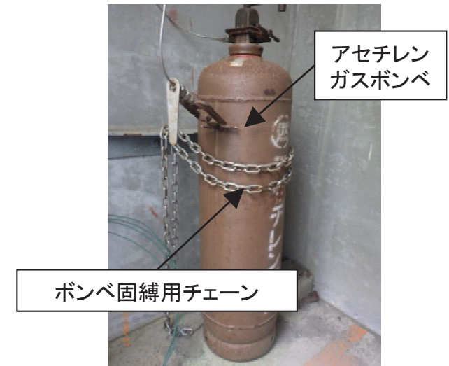
図17 発電所におけるボンベの設置状況
