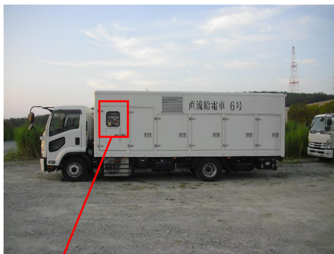
直流給電車操作部
