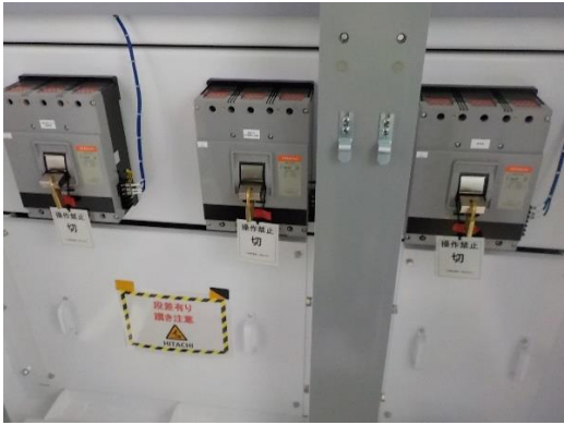
同時投入防止用切替盤
