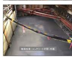
地盤改良工事の状況(令和3年12月)
