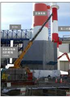
主排気筒の筒身補強工事の状況 (令和3年12月)
