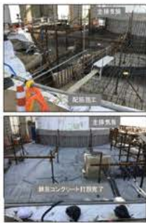
主排気筒の基礎補強工事 (令和3年7月~10月終了)
