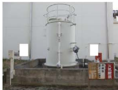
既設の灯油貯槽
