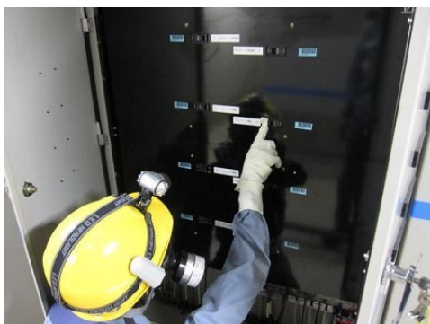
直流電源受電操作 （充電器室）
