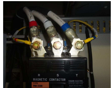
【直流き電盤内NFB2次側へ接続】
