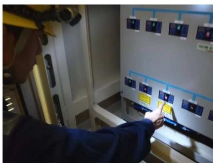
直流電源受電操作 （中間建屋 E.L. +10.1m）
