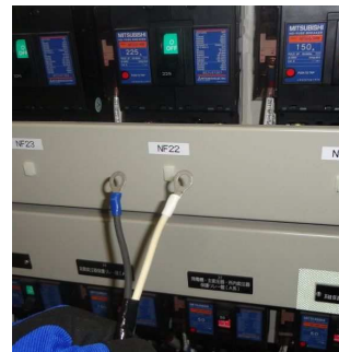
【直流き電盤内NFB2次側へ接続】
