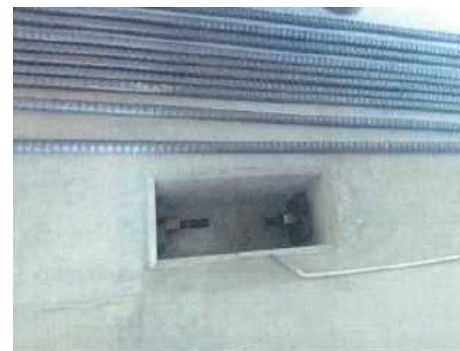
切り欠き部のモルタル充填
