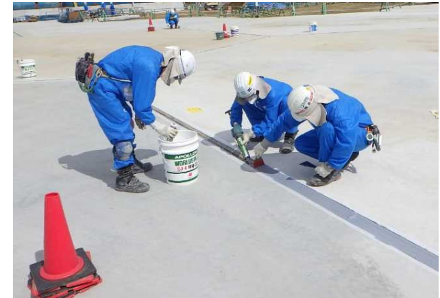
止水対策の施工状況の一例 (目地シーリング材)
