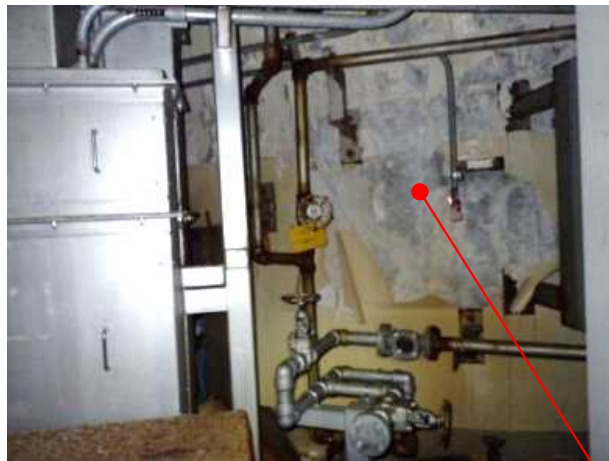
写真b：シェル壁北西面
