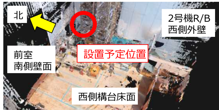
2号機R/B構台上 (5階レベル)
