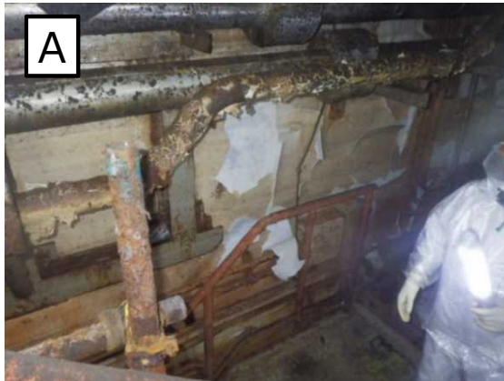
地下2階内壁面A
