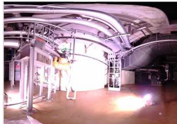
3階シェル壁北東面（写真）
