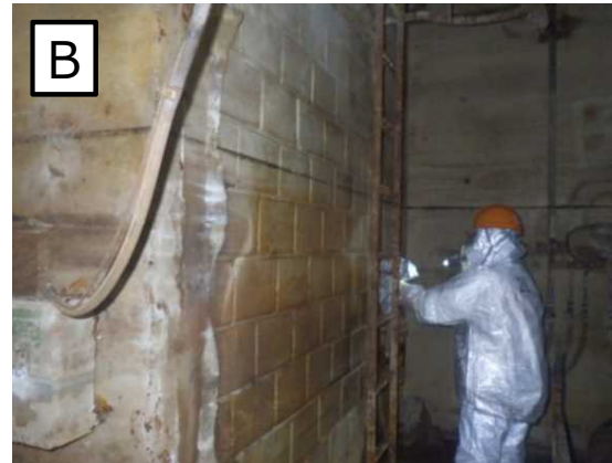
地下2階内壁面B
