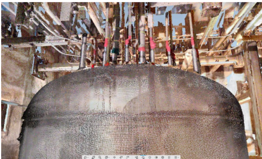
3D点群データの例（セル内に設置された円筒槽の頂部）
