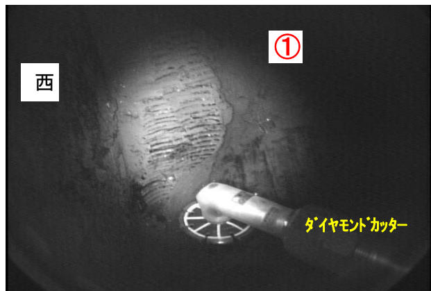
①西側炉底傾斜面上部のはつり作業(R3.1.7)
