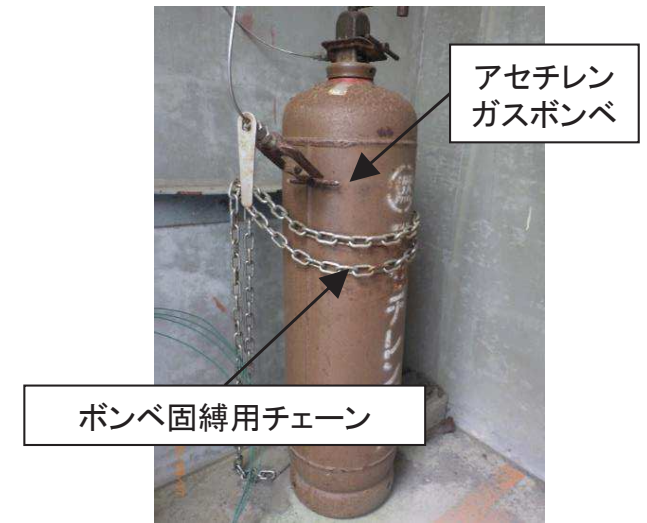
図17 発電所におけるボンベの設置状況
