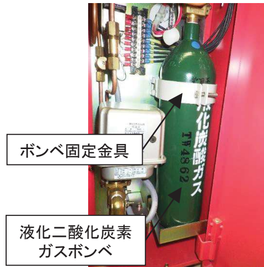
図17 発電所におけるボンベの設置状況
