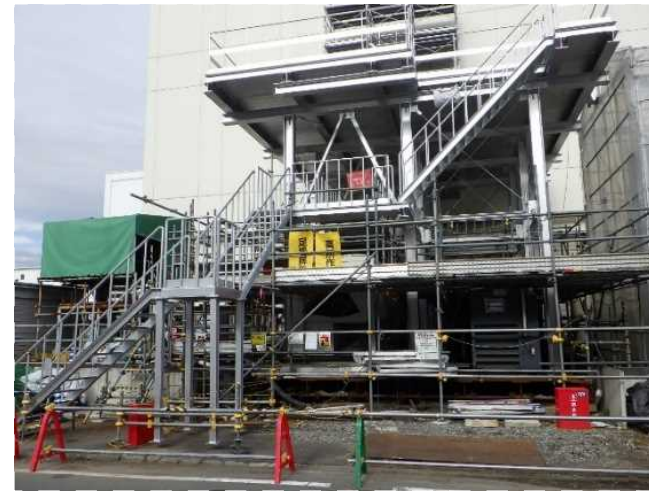
① 仮設構台 (設置完了)
