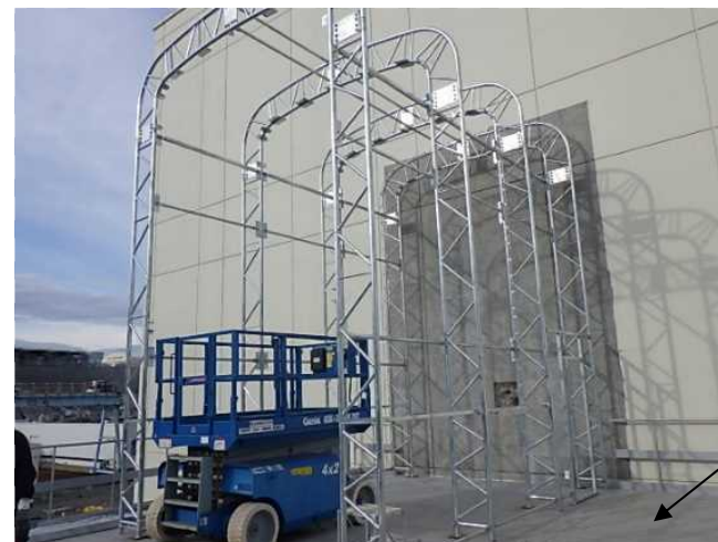
③ クリーンハウス (設置中)
