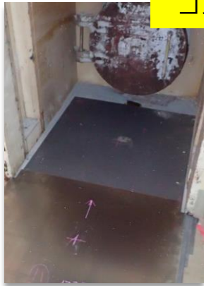
コンクリート打設後、 敷き鉄板を敷設した状態
