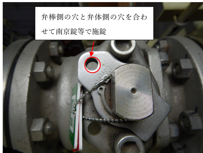
図 4.2 弁の施錠イメージ (廃液)
