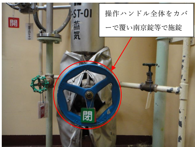
図 4.3 弁の施錠イメージ (加熱蒸気)
