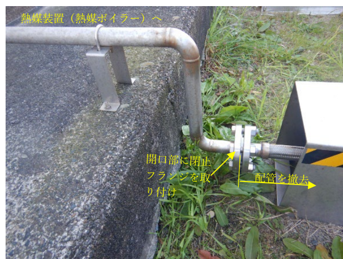
図 4.4 閉止フランジによる閉止イメージ(LPG)
