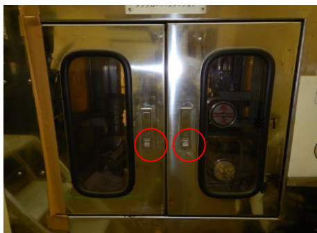
① 廃液の受入口 (タンクローリステーション) の扉を施錠
