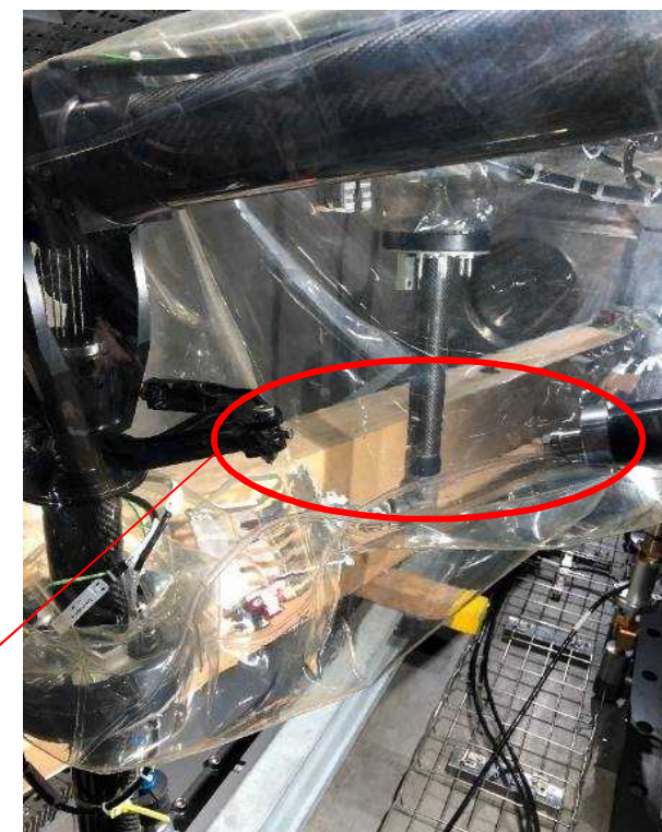
ボルトが破断して接続部 が離れた状態
