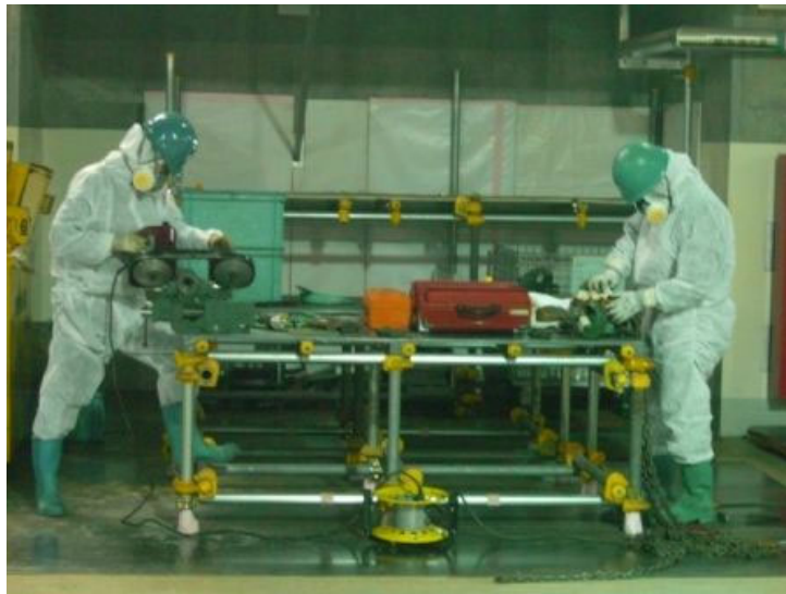
第 27－9 図 切断作業の状況
